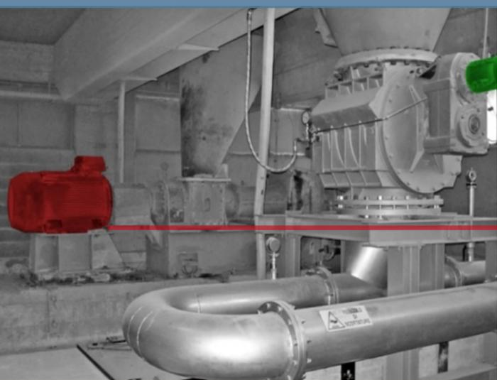
**Válvulas rotativas (~25 rpm)**
